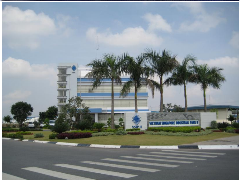
NHÀ MÁY, NHÀ XƯỞNG FACTORY
