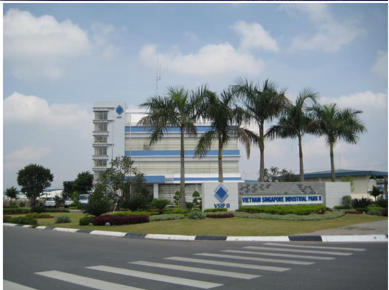
NHÀ MÁY, NHÀ XƯỞNG FACTORY
